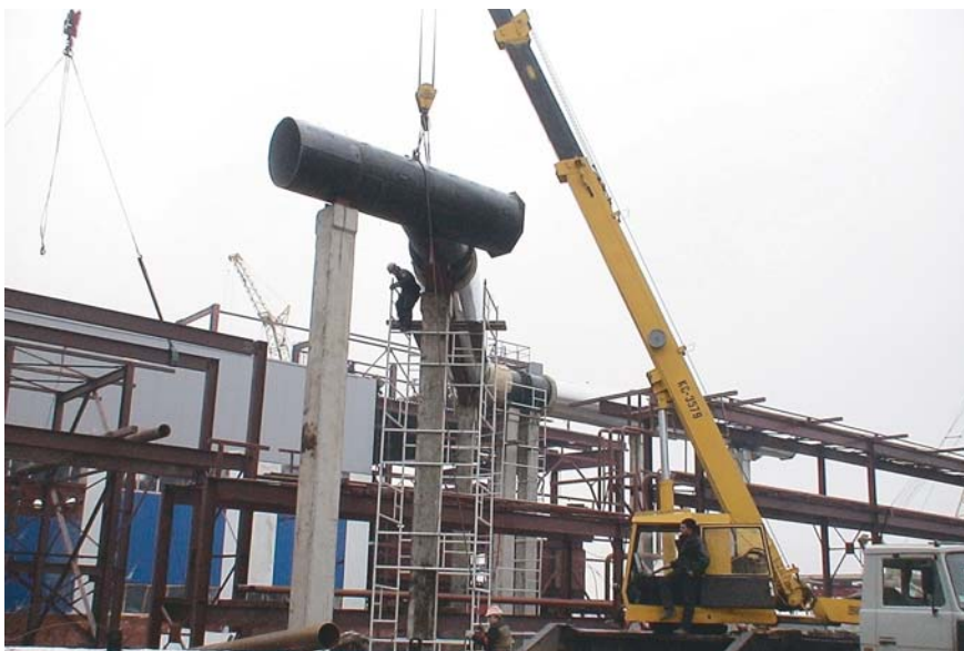
Специалисты РУП «Белэнергострой» ведут монтажные работы на мини-ТЭЦ в Осиповичах
