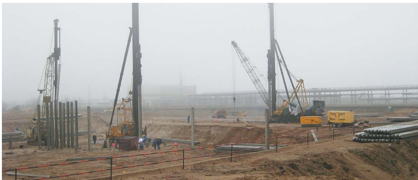
Начало строительных работ на Минской ТЭЦ-5
